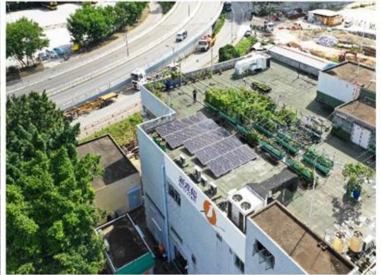
新渡輪於荔枝角辦公大樓天台投放了25萬元，建造「新渡輪太陽能天地」佔地約53平方米，鋪設共27塊太陽能發電板，於10月12日連接電網參與「上網電價」計劃。首年預計可產生約1萬度電，每年慳5萬元電費，約六年內便可回本。
