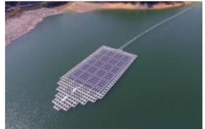
船灣淡水湖浮動太陽能板發電系統
