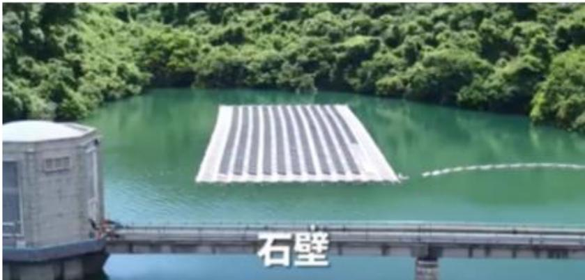
石壁水塘浮動太陽能發電系統
